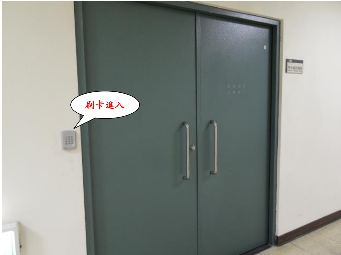
圖 17. 第二層網路機房外門
