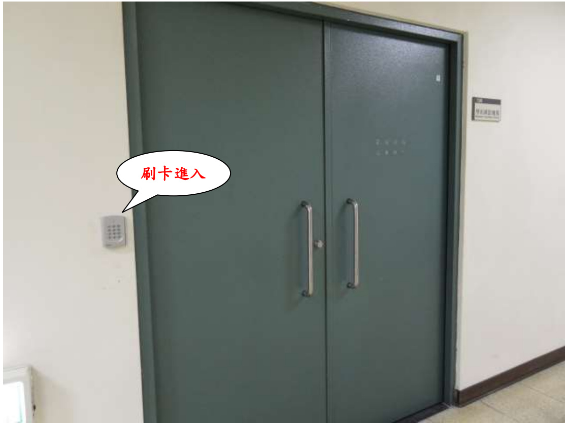
圖 17. 第二層網路機房外門
