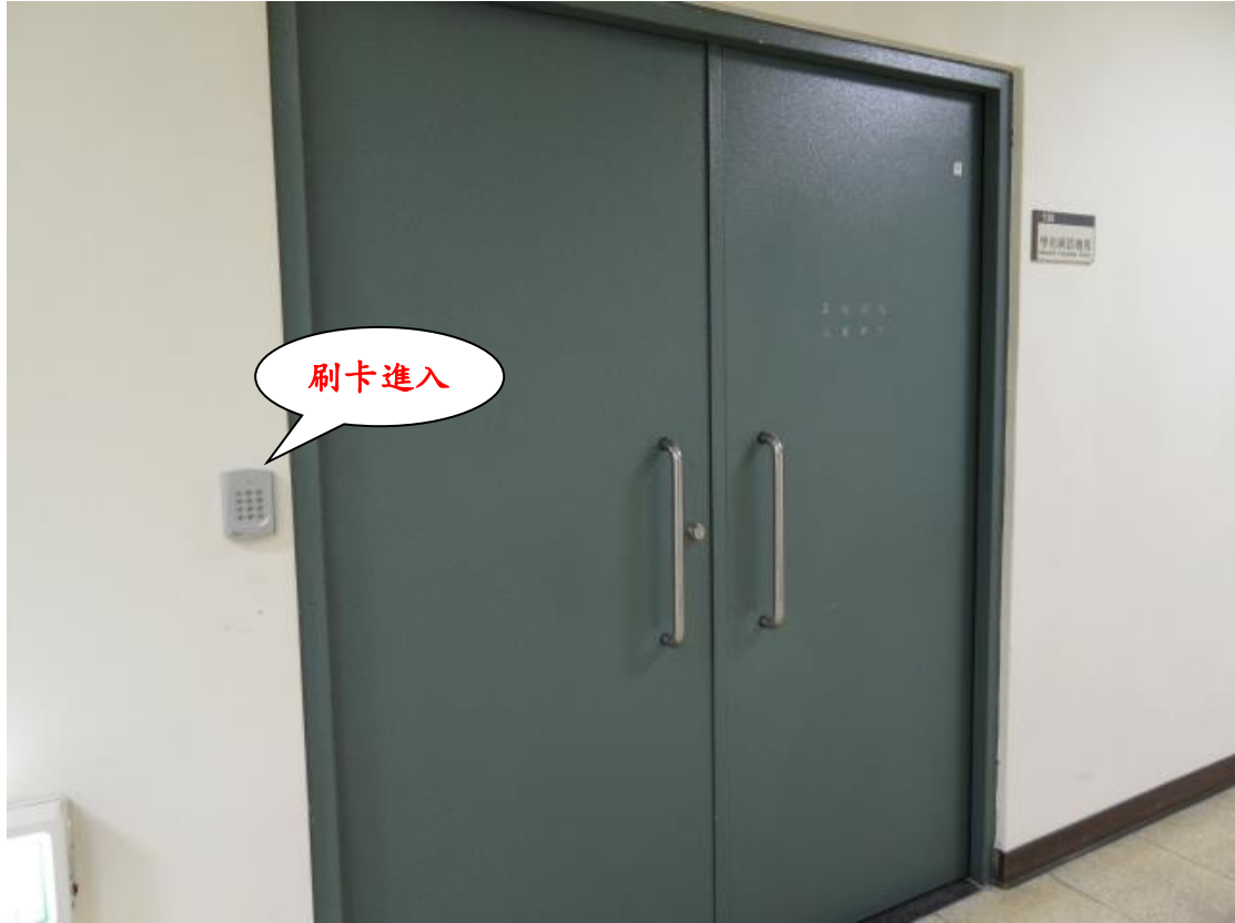
圖 17. 第二層網路機房外門
