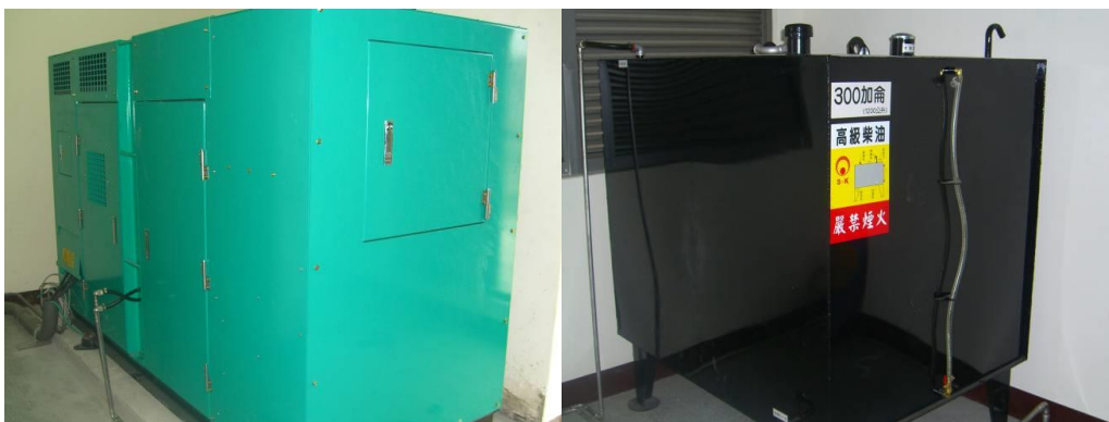
圖 5.網路機房發電機及油箱
