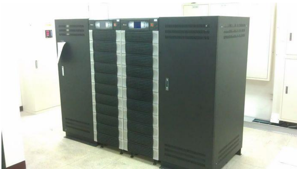
圖 4.不斷電系統主機
